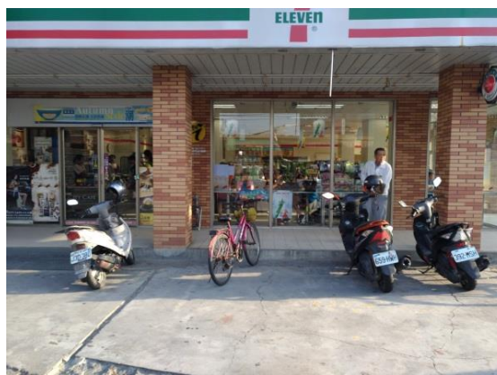
統一超商-自動開啟的透明落地門
